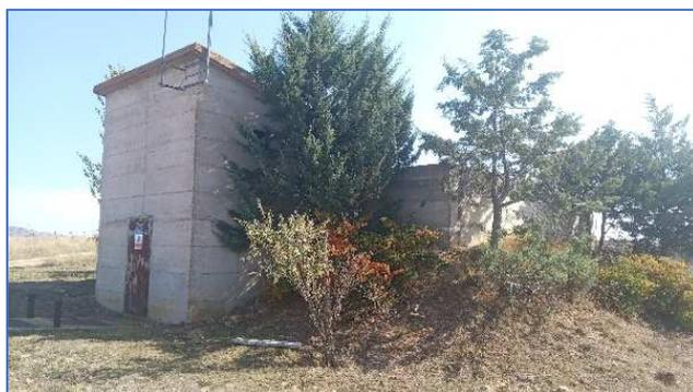
Para el presente Proyecto, el punto origen sobre el que se centra nuestro nuevo sistema de abastecimiento es el depósito denominado “Urbanización Numancia”. Se trata de un depósito construido en hormigón armado con una capacidad de 200 m<sup>3</sup>, dividido en dos vasos de 100 m<sup>3</sup> cada uno, situándose al este de la localidad de Garray. Se abastece desde la ETAP de la CMA mediante una impulsión de PVC orientado de diámetro 140 mm.
