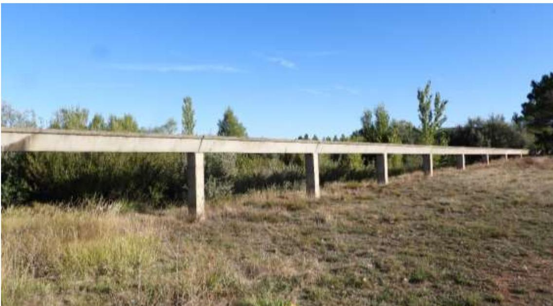
Imagen 1: Canal de riego con su funcionamiento por gravedad (*Fuente: Molina L.E. 2019*)
